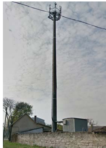
Önálló antennatartó szerkezet (XXII. ker., Vágóhíd u.)
